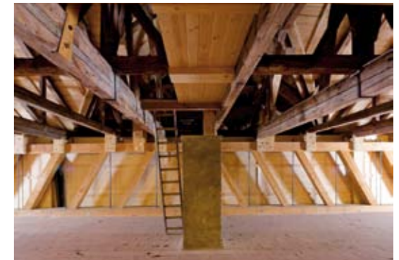
1 Stift Stams, Gesamtansicht 2 Dachstuhlkonstruktion Bernardisaal Fotos BDA
